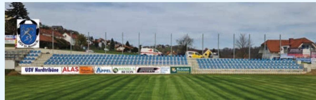
▲ Die neu errichtete Nordtribüne
